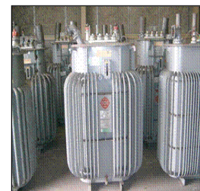
トランス（変圧器）
