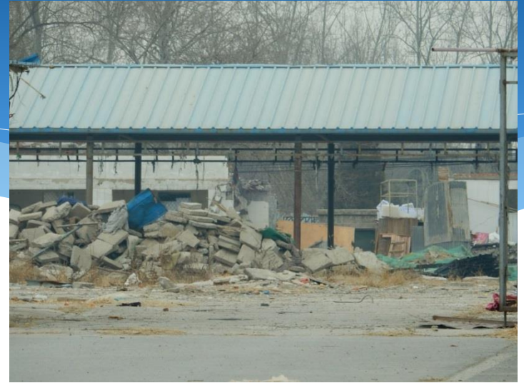
市北西部の建築物解体跡地？
