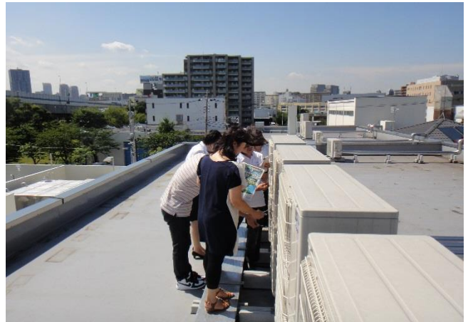
(エアコン室外機の熱風を測る)
