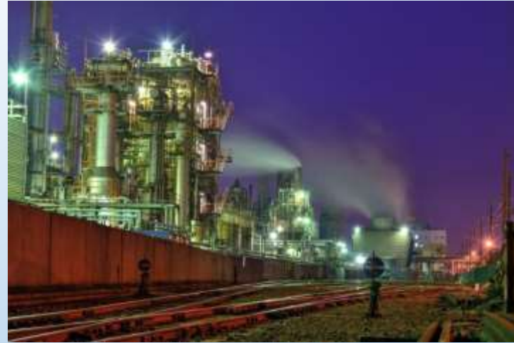
鉄鋼業等の工場
