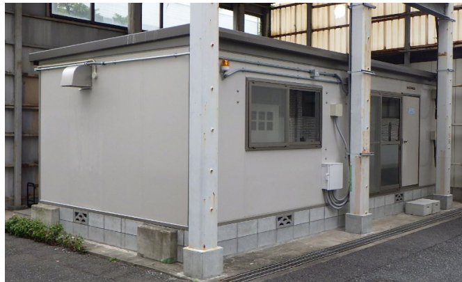
水素蓄電実験室 ※プレハブ型16畳
