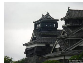
平成28年4月熊本地震 (熊本県熊本城)
