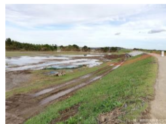
令和元年10月台風19号 (埼玉県川越市荒川水系 入間川流域堤防決壊)
