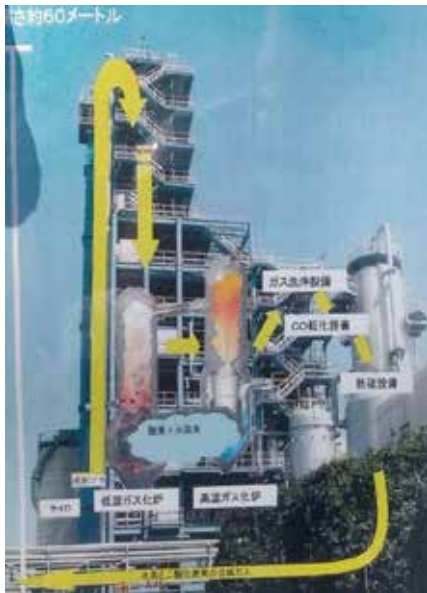
ガス化炉説明図
