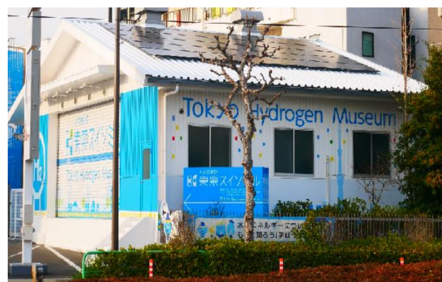
倉庫棟屋根に設置された太陽光発電
