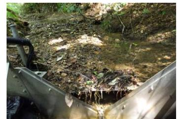
図5 土砂に埋没した堰の状況
