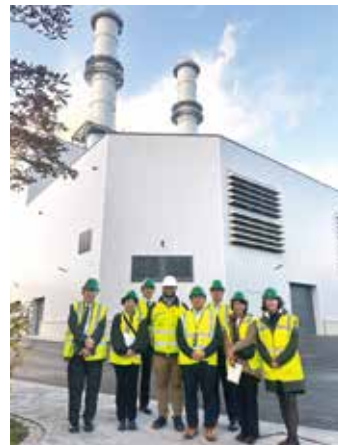
EnBWの水素対応CHPプラント(後方)
