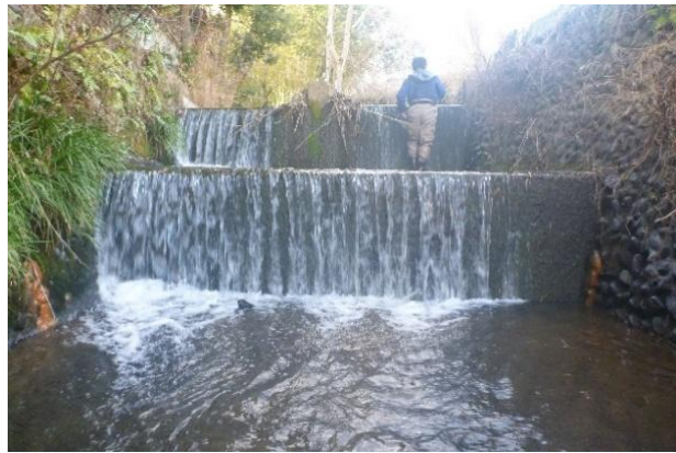
落差高の大きい堰A(計1.9m)
