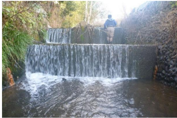
落差高の大きい堰A(計1.9m)
