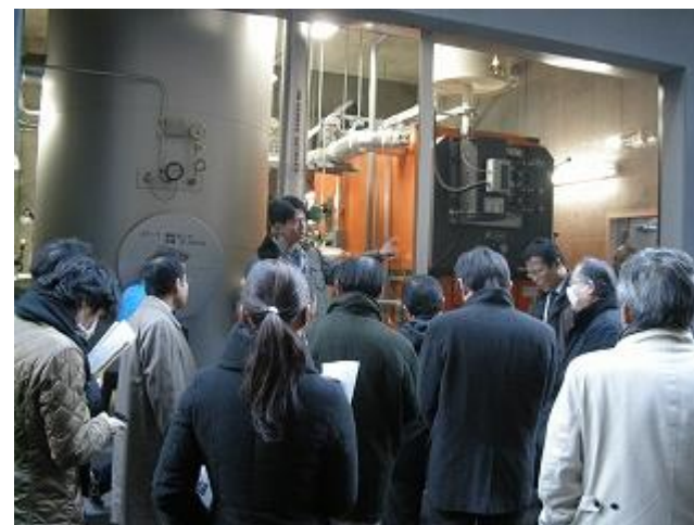
木質バイオマスボイラー（奥多摩温泉 もえぎの湯）
