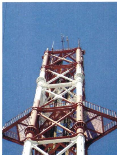
屋上鉄塔（最上部に放射関係測定機器を設置）
