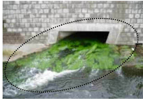
写真 1 中野処理場・放流口 マツバイ等の水生植物が大量に繁茂している（円内）
