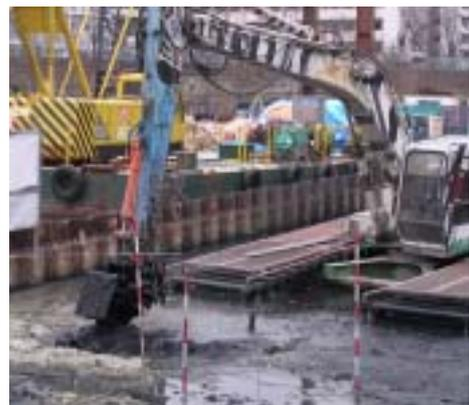
写真 横十間川天神橋と同地区のセメント固化作業風景
