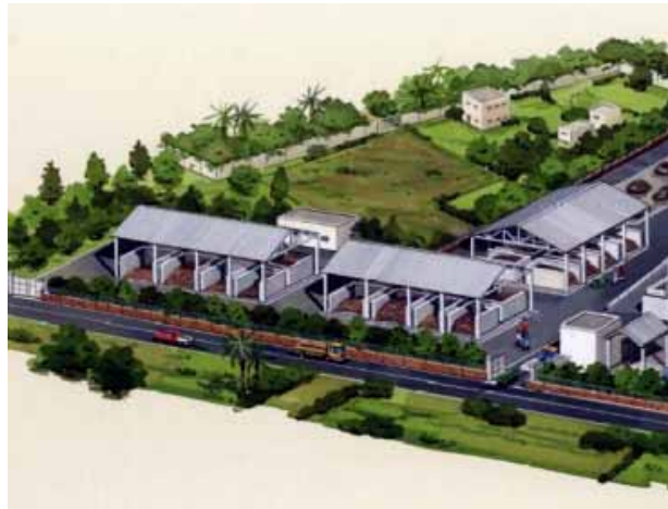
建設中のコンポスト処理施設
