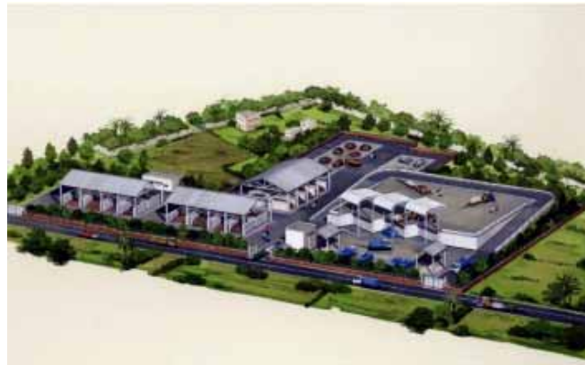
建設中の中継基地
