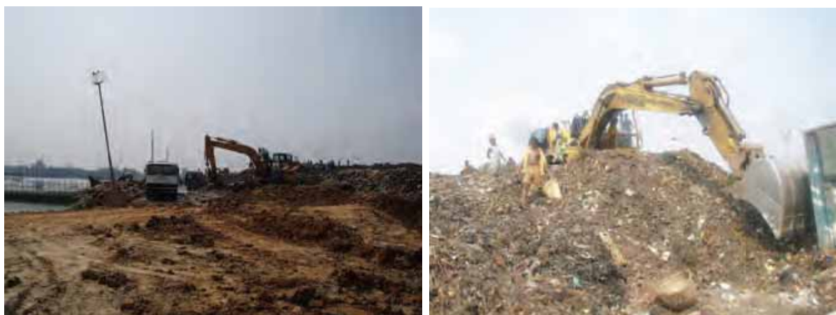
写真) 埋め立て作業の様子。
