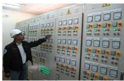
コントロールルーム
