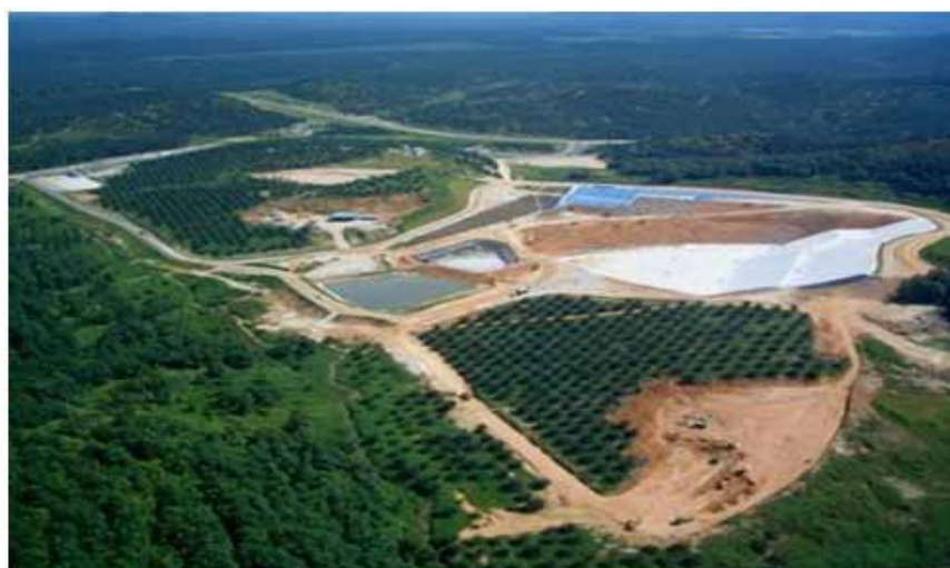
写真 3: Bukit Tagar 埋め立て処分場
