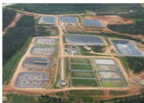
浸出水処理施設
