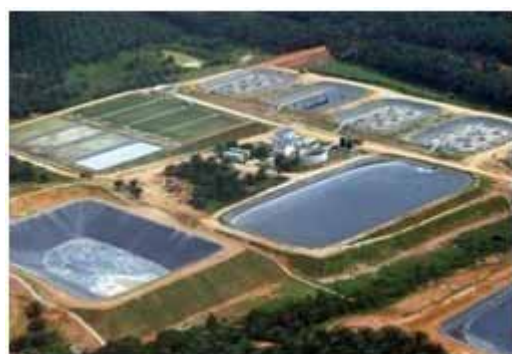
浸出水処理施設
