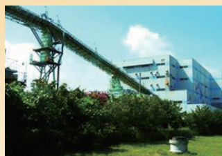
中防不燃ごみ処理センター
