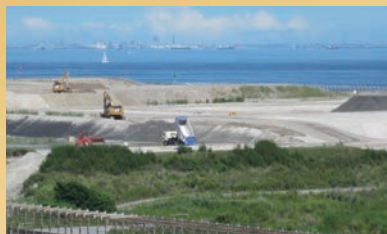
中央防波堤新海面埋立処分場での作業
