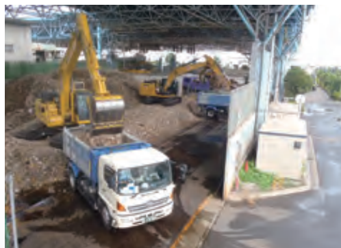
粗大破碎済みごみの積込み作業 (東京二十三区清掃一部事務組合提供)
