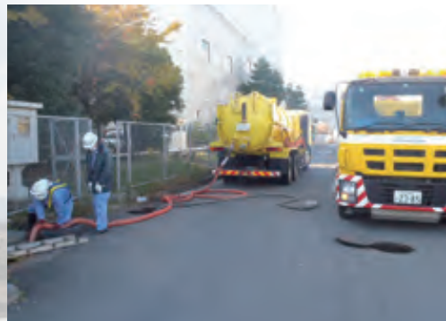
雨水槽の清掃作業 (東京二十三区清掃一部事務組合提供)
