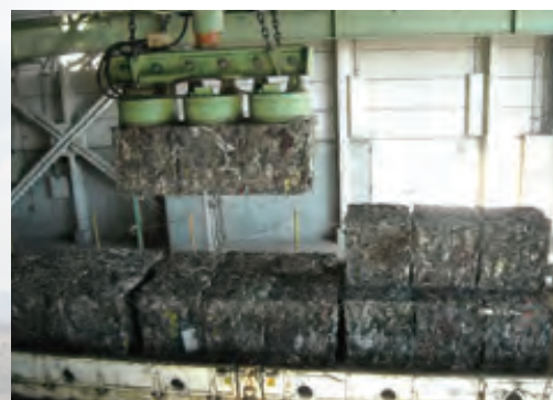
京浜島鉄分貯留ヤード (東京二十三区清掃一部事務組合提供)
