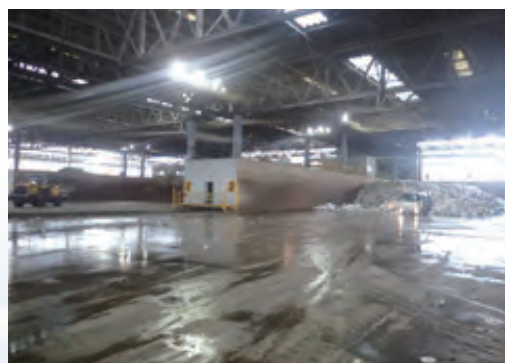
中防不燃ごみ貯留ヤード (東京二十三区清掃一部事務組合提供)
