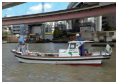
小型手作業船での清掃作業
