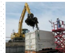
災害廃棄物搬出時の受入監視の様子
