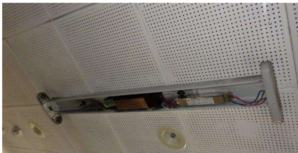
LED化照明器具内部（本体は未交換）
