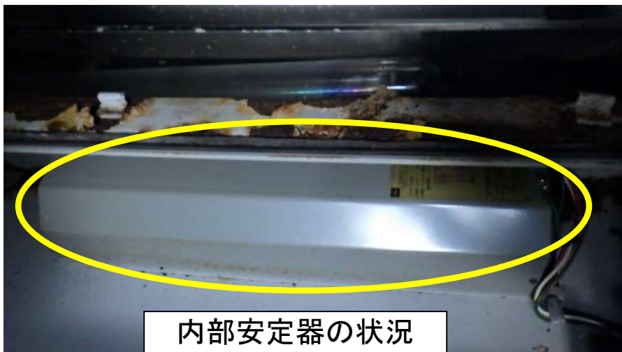
トンネルナトリウム灯（崩落寸前）
