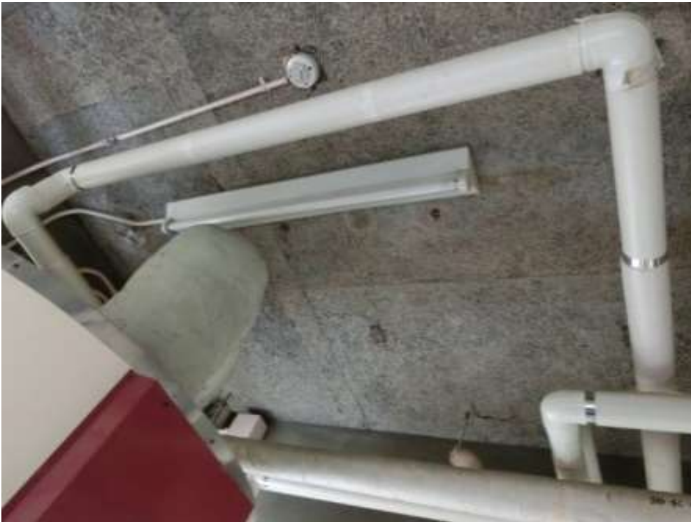
ボイラー上部
