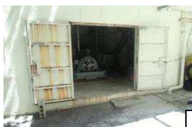
安定器が残置されていた 倉庫（入口）
