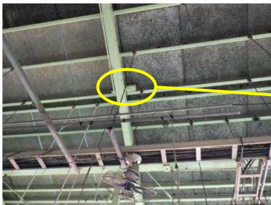
水銀灯安定器の残置状態 (灯具は既になく、安定器のみが残置)
