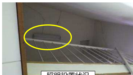
照明設置状況
