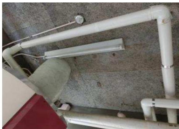
ボイラー上部
