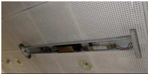
LED化照明器具内部（本体は未交換）
