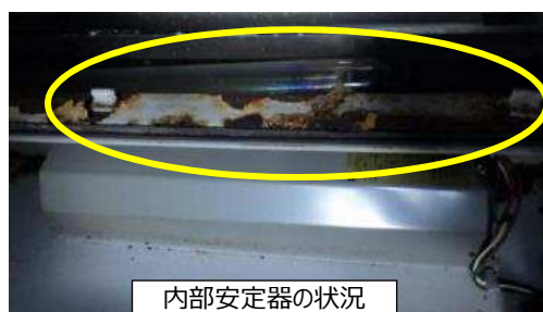
トンネルナトリウム灯（崩落寸前）
