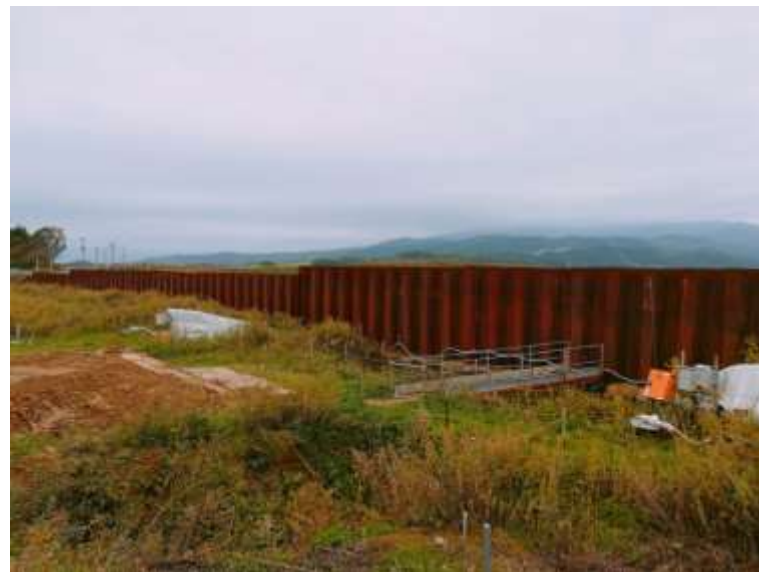
県境には、鋼矢板が残されていたが、地上露出部は景観に配慮して、令和3年にようやく撤去する事案が了承された。（地下埋設部は残置）
