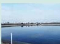
処分場に降った雨は、ごみ層を通して調整池に集められます。調整池で水量や水質を調整し、排水処理場に送水しています。
