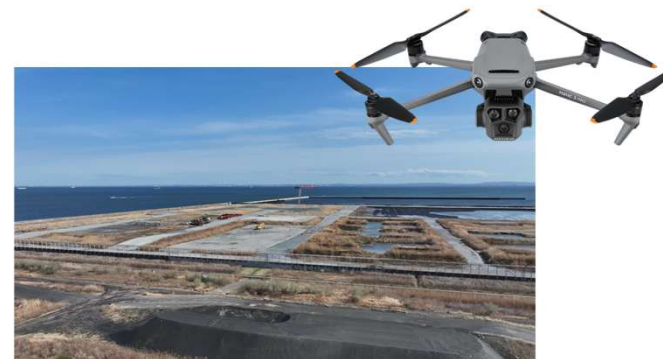
ハイエンドドローンで撮影した埋立処分場
